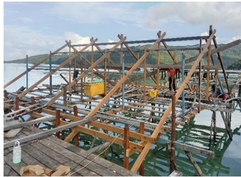
Gambar 1. Pembuatan Bagan Jaring Apung
